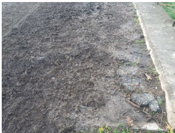
Fot. 89 Widok nawierzchni jezdni i kapy chodnikowej
