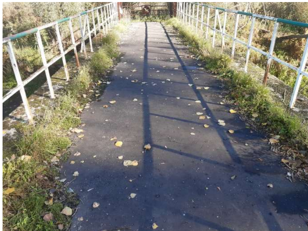
Fot. 136 Widok nawierzchni jezdni i kapy chodnikowej
