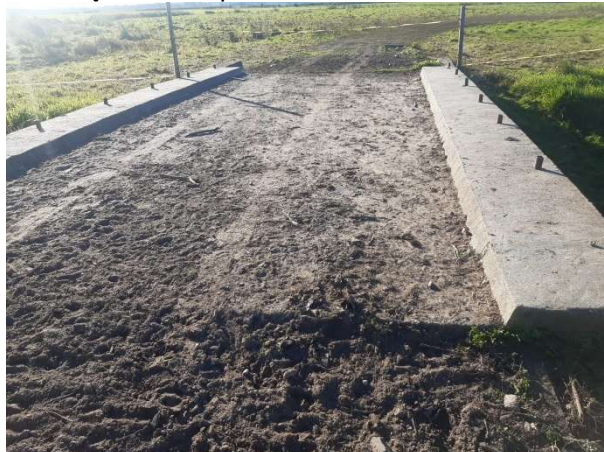
Fot. 157 Nawierzchnia jezdni i kapy chodnikowe mostu na drodze nr 19(1)
