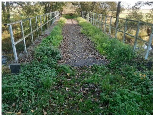
Fot. 102 Balustrady stalowe
