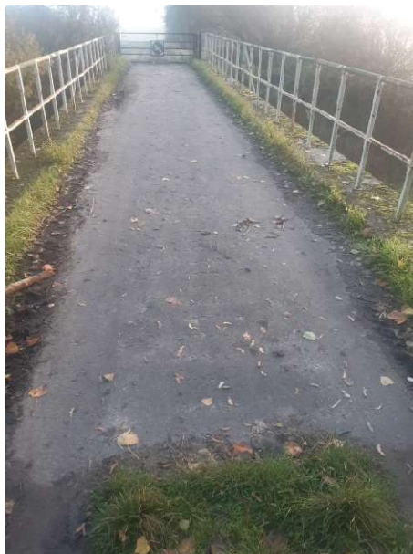
Fot. 114 Widok nawierzchni jezdni i kapy chodnikowej
