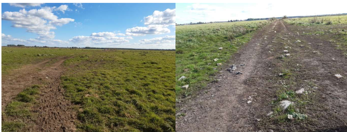
Fot. 43 Droga nr 21
