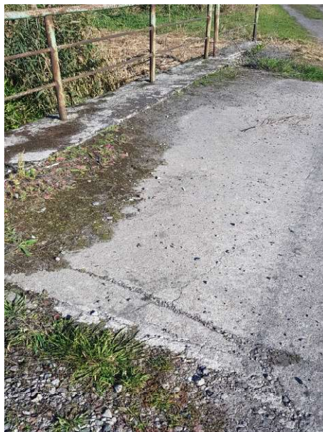
Fot. 142 Nawierzchnia jezdni mostu
