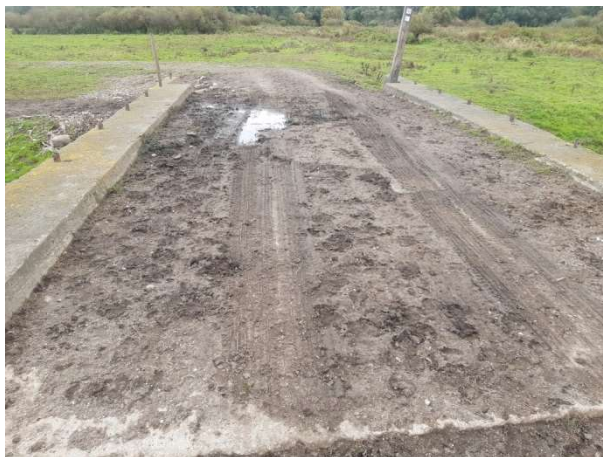
Fot. 73 Widok nawierzchni jezdni i kapy chodnikowej
