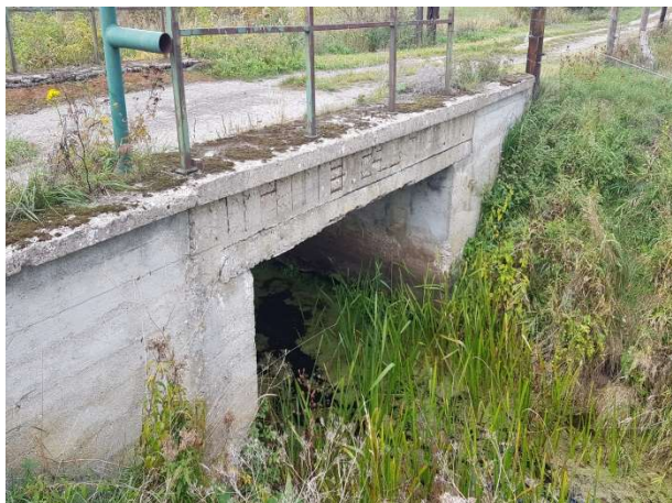
Fot. 137 Most w ciągu drogi nr 1
