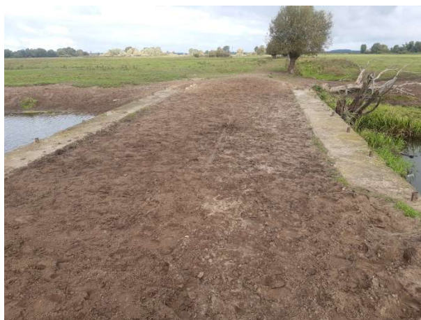
Fot. 124 Widok nawierzchni jezdni i kapy chodnikowej
