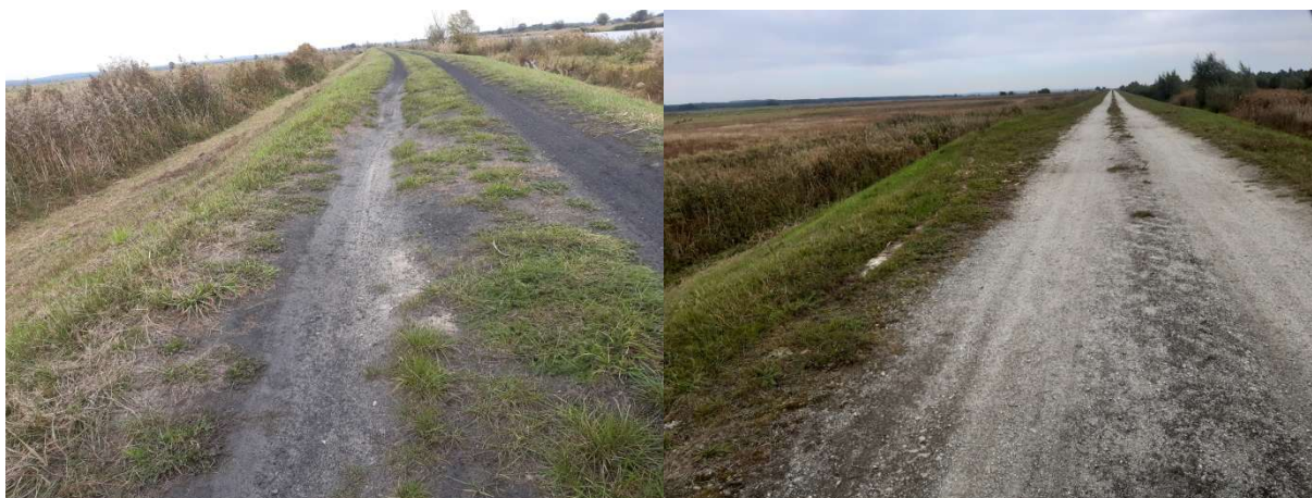
Fot. 9 Droga nr 7
