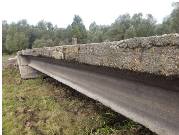
Fot. 128 Stan dźwigarów głównych
