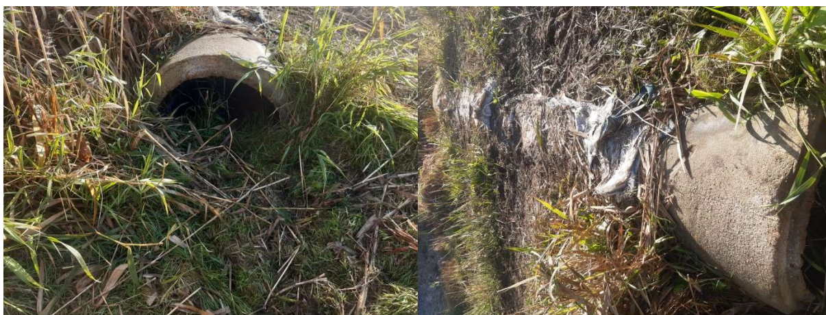
Fot. 55 Przepust na drodze nr 27 (kilometraż 1+364)
