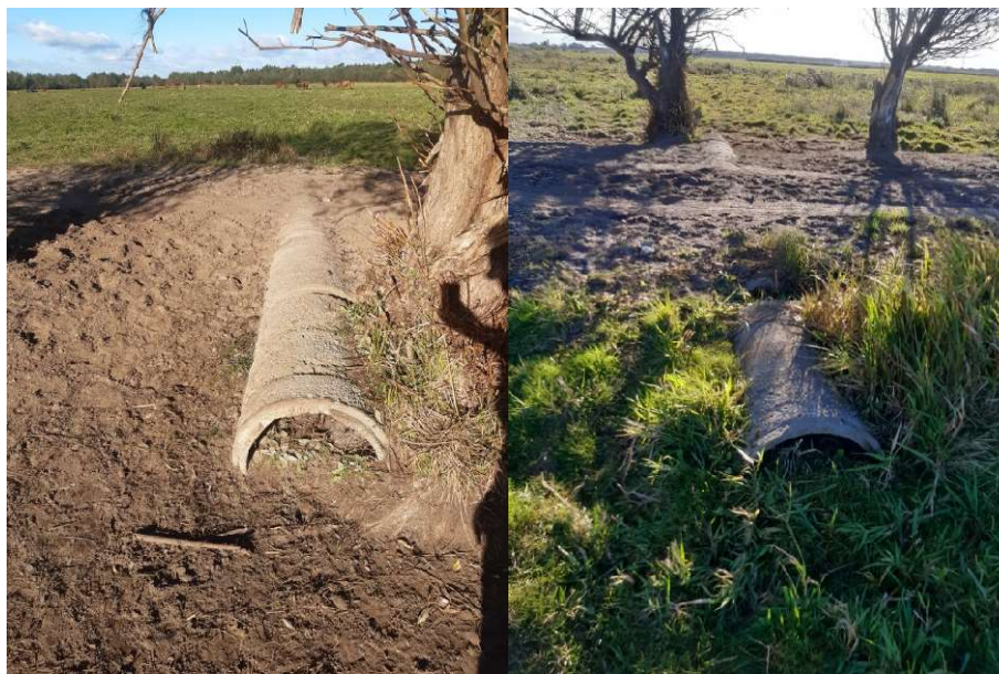
Fot. 39 Przepust na drodze nr 19 (kilometraż 1+277)
