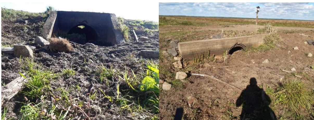
Fot. 49 Przepust na wjeździe na drogę nr 24 (kilometraż 0+011)
