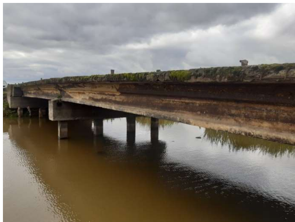
Fot. 66 Stan dźwigarów głównych
