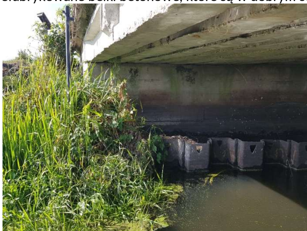
Fot. 141 Spodnia strona mostu
