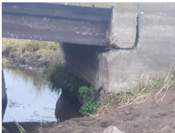
Fot. 106 Szczeliny dylatacyjne
