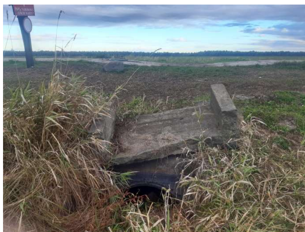
Fot. 31 Przepust na drodze nr 16 (kilometraż 0+192)
