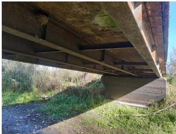
Fot. 135 Stalowe dźwigary główne i spodnia strona pomostu
