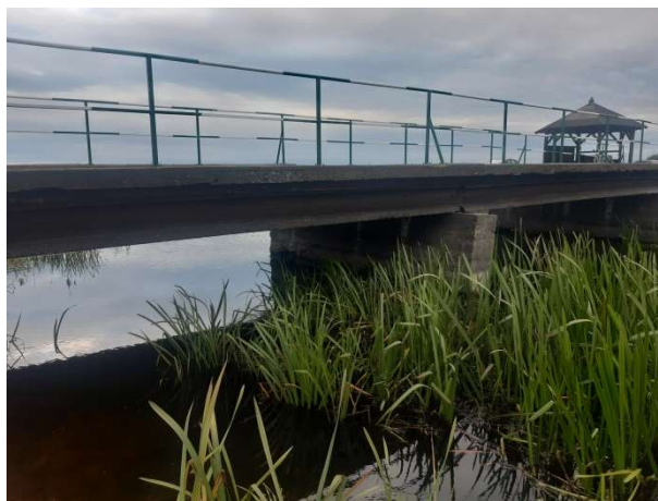
Fot. 107 Stan dźwigarów głównych
