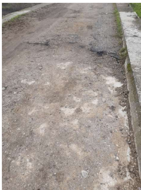
Fot. 67 Widok nawierzchni jezdni i kapy chodnikowej
