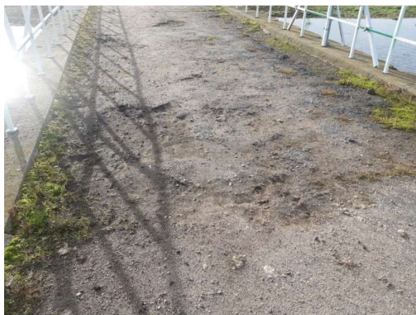
Fot. 79 Nawierzchnia jezdni i kapy chodnikowe
