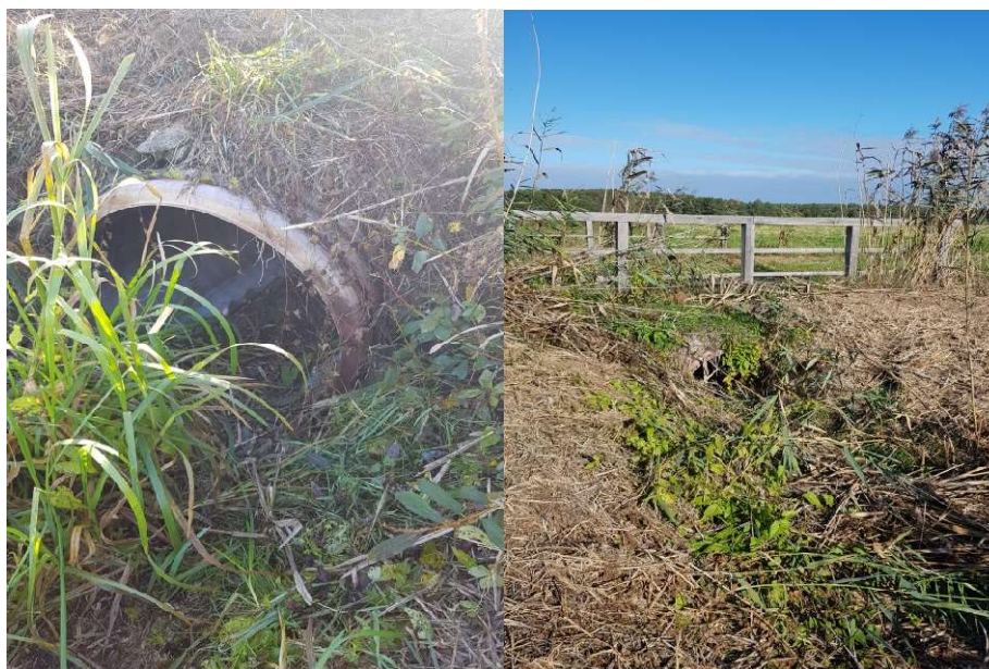
Fot. 5 Przepust na drodze nr 3 (kilometraż 0+010)
