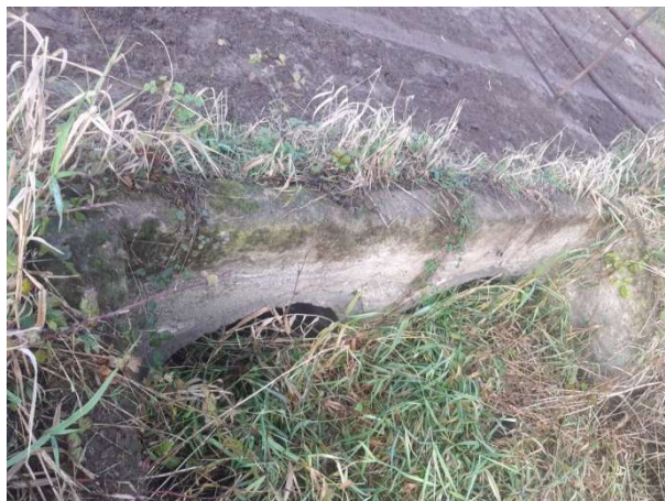
Fot. 82 Ściana oporowa
