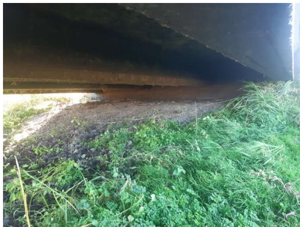
Fot. 156 Spodnia strona w dźwigarami głównymi mostu na drodze nr 19(1)
