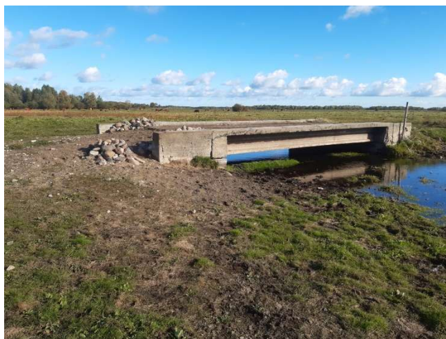
Fot. 161 Most na drodze numer 19(3) na kilometrażu 2+827
