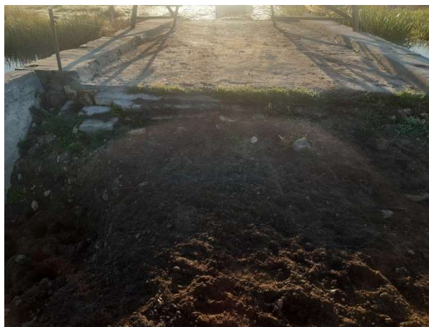
Fot. 169 Połączenie drogi z mostem
