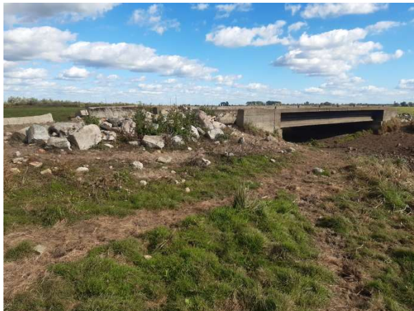
Fot. 163 Most na drodze nr 21
