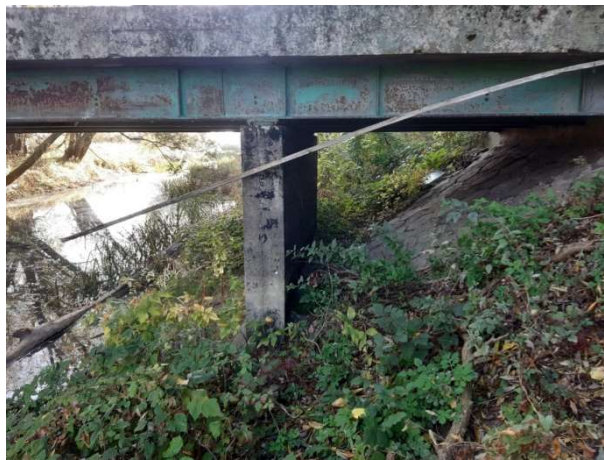
Fot. 99 Filar z łożyskiem
