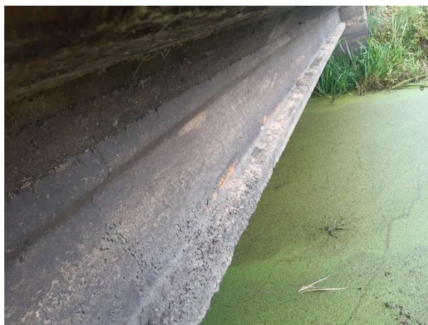
Fot. 119 Stan dźwigarów głównych
