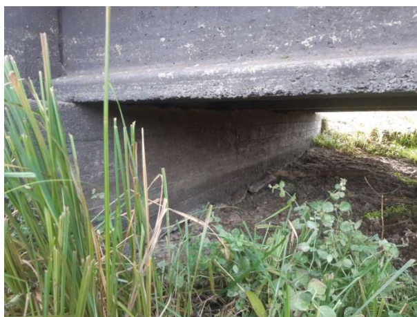
Fot. 91 Podpora skrajna
