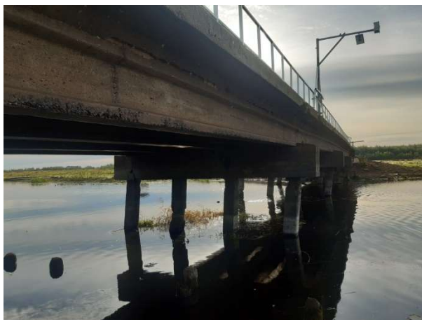
Fot. 77 Dźwigary główne
