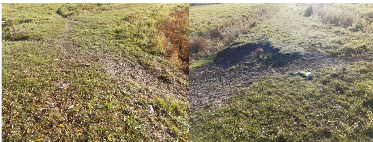
Fot. 59 Droga nr 29
