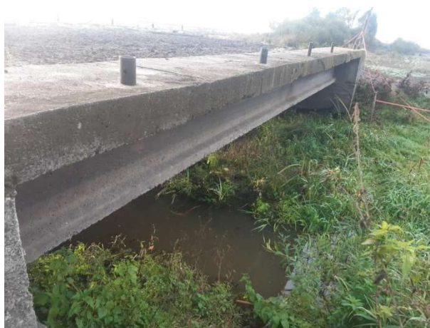
Fot. 87 Dźwigary główne
