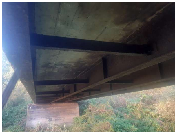
Fot. 113 Stalowe dźwigary główne i spodnia strona pomostu
