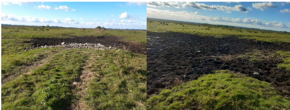
Fot. 40 Miejsce zniszczonej korony drogi - przejścia bydła
