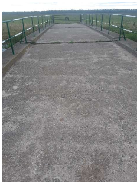
Fot. 109 Widok nawierzchni jezdni i kapy chodnikowej
