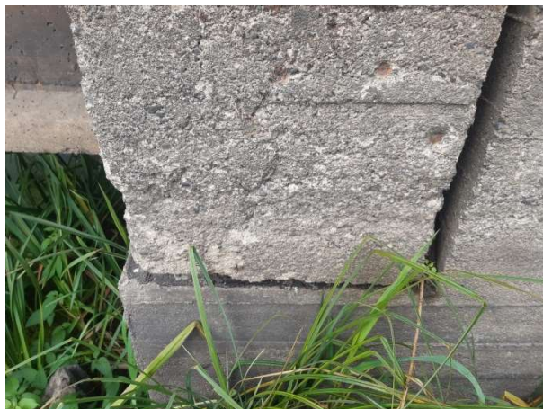
Fot. 118 Szczeliny dylatacyjne
