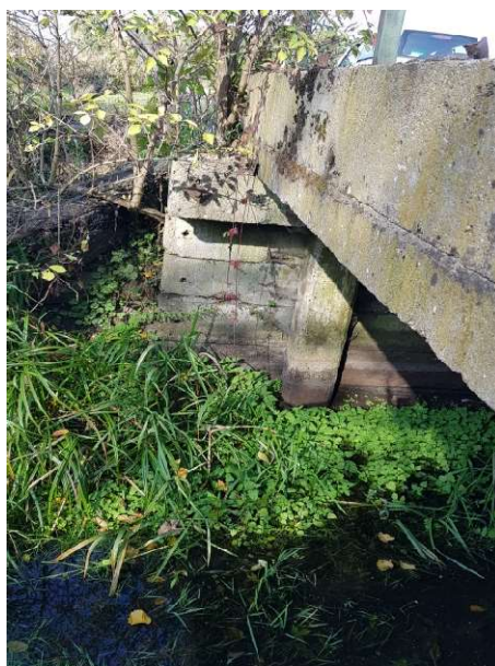
Fot. 149 Przyczółek mostu drodze numer 6 na Kanale Warnickim
