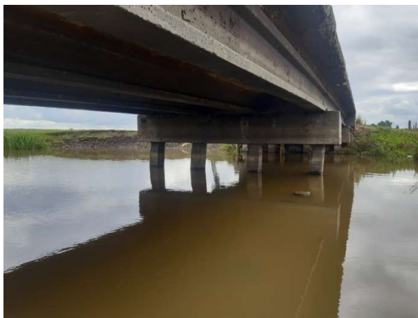
Fot. 63 Przesunięcie oczepu
