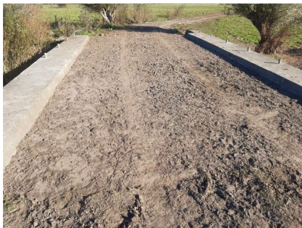
Fot. 160 Nawierzchnia jezdni i kapy chodnikowej drogi numer 19(2)
