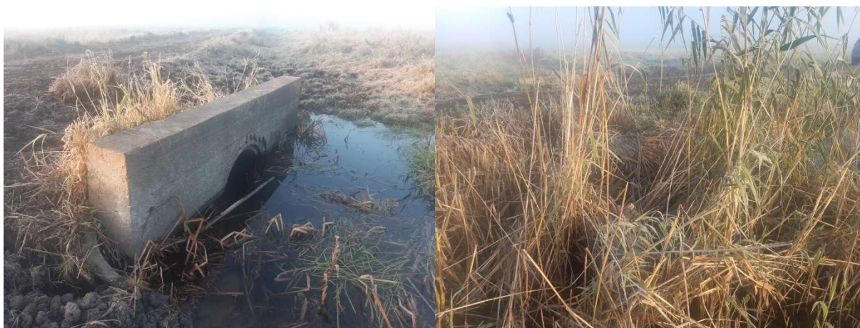
Fot. 58 Przepust na drodze 28 (kilometraż 0+439)
