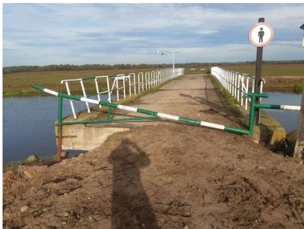
Fot. 80 Balustrady stalowe
