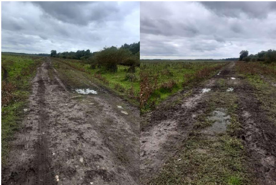
Fot. 24 Droga nr 15 fragment z nawierzchnią żwirową
