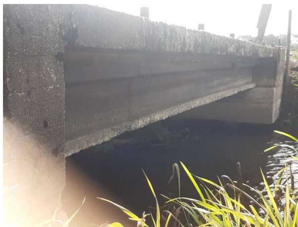
Fot. 123 Stan dźwigarów głównych
