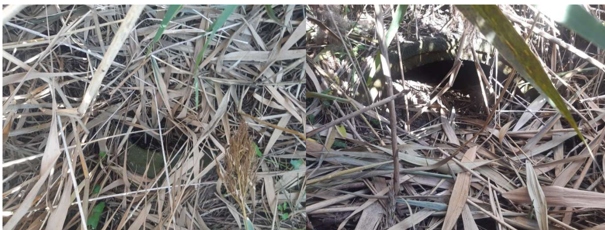
Fot. 56 Przepust na drodze nr 27 (kilometraż 2+048)
