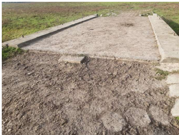
Fot. 96 Połączenie drogi z mostem
