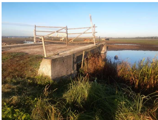
Fot. 167 Most na drodze numer 23
