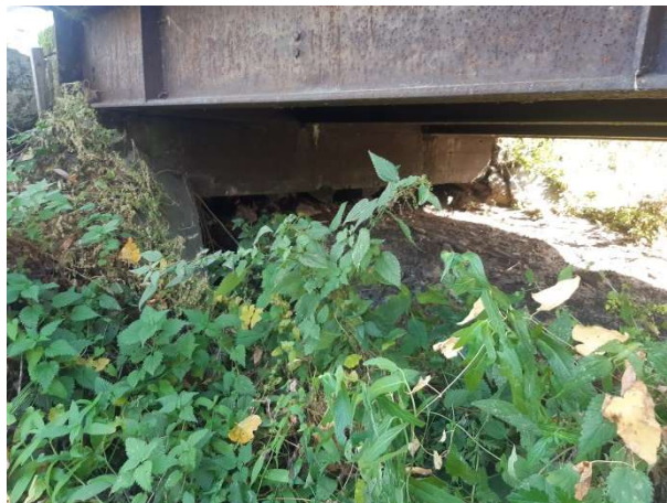
Fot. 133 Przyczółek wraz z nasypem drogi
