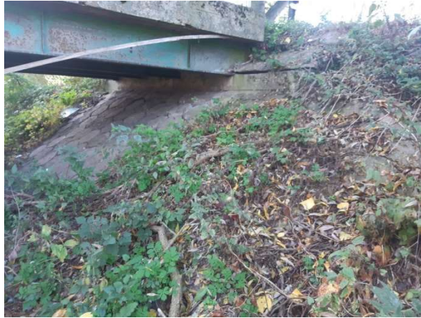
Fot. 98 Przyczółek wraz z nasypem drogi
