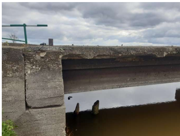
Fot. 65 Szczeliny dylatacyjne
