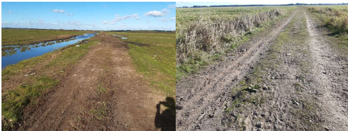
Fot. 45 Droga nr 23
