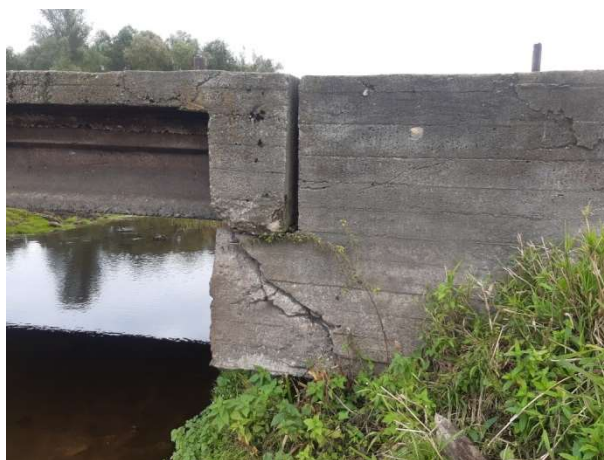
Fot. 70 Szczeliny dylatacyjne
