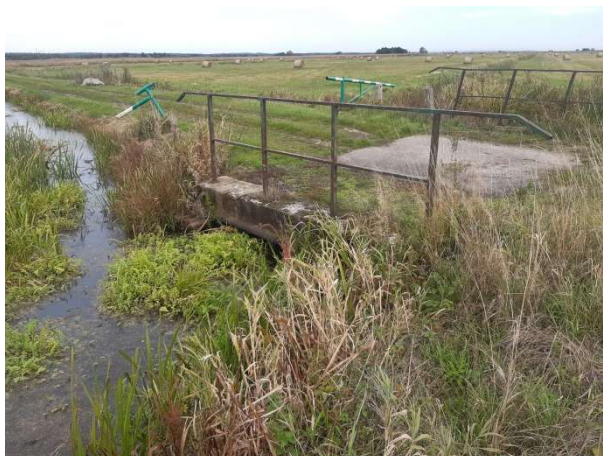
Fot. 150 Most na drodze numer 12
