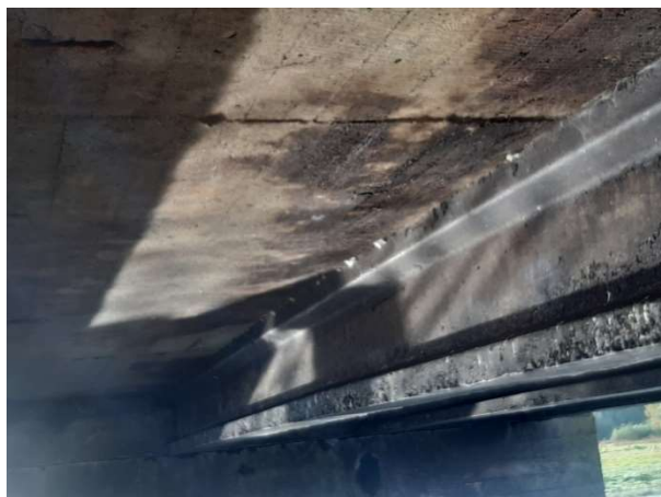
Fot. 78 Spodnia strona płyty pomostu
