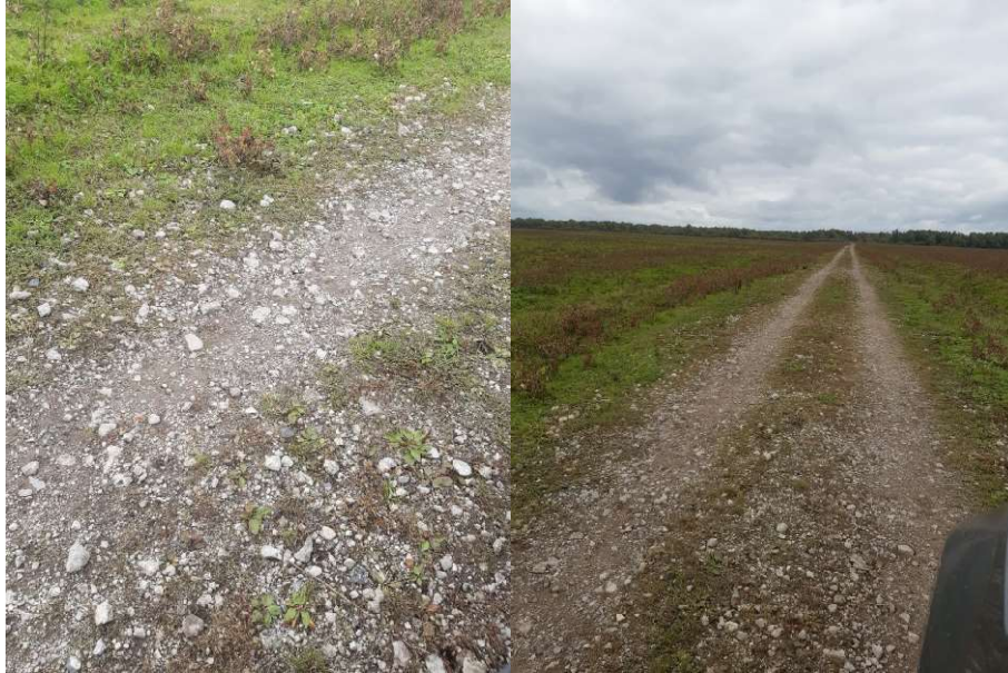
Fot. 21 Droga nr 15 fragment z nawierzchnią z destruktu budowlanego
