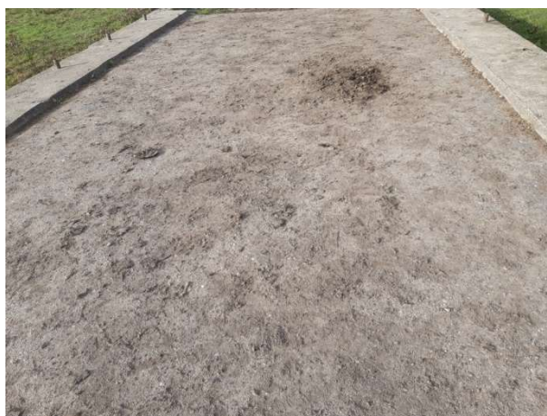
Fot. 95 Widok nawierzchni jezdni i kapy chodnikowej
