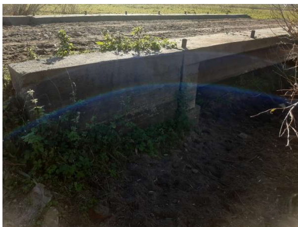
Fot. 158 Most na drodze numer 19(2) na kilometrażu 1+563
