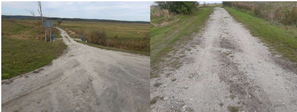
Fot. 19 Droga nr 13
