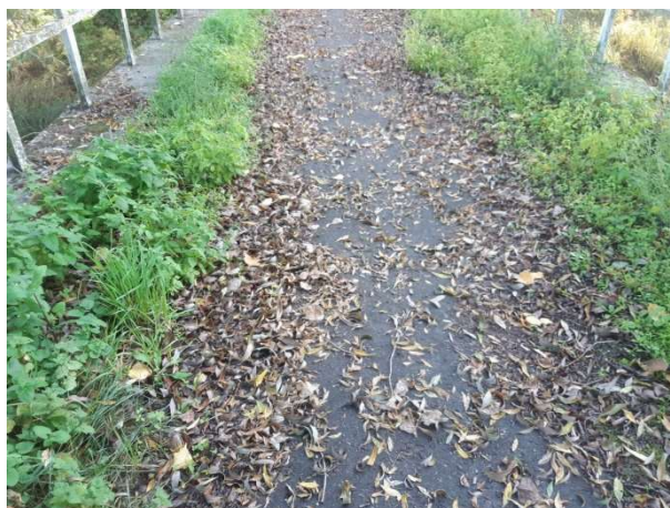
Fot. 101 Widok nawierzchni jezdni i kapy chodnikowej
