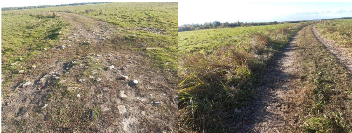
Fot. 38 Droga nr 19
