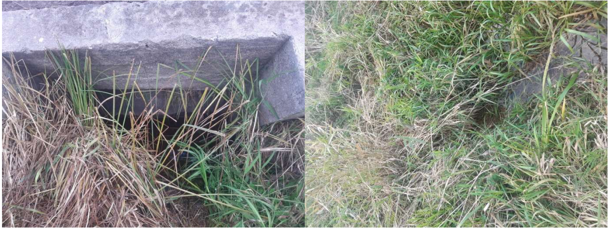
Fot. 32 Przepust na drodze nr 16 (kilometraż 1+911)
