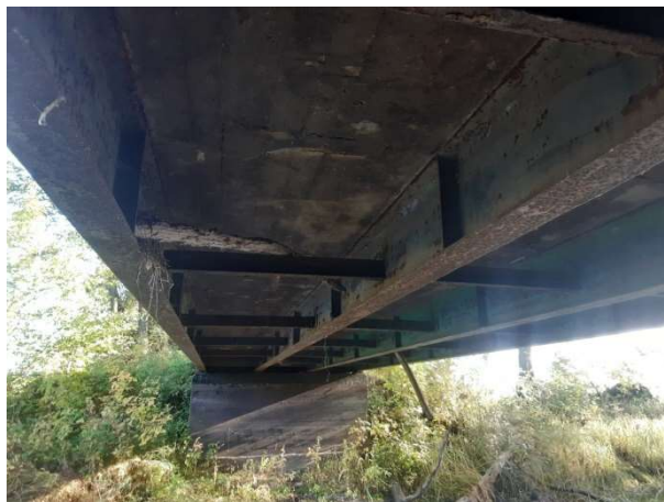
Fot. 100 Stalowe dźwigary główne i spodnia strona pomostu
