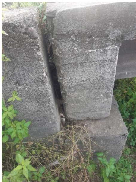
Fot. 86 Szczelina dylatacyjna
