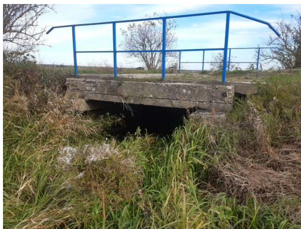
Fot. 152 Most na drodze numer 13
