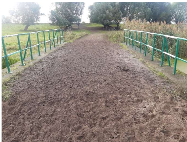
Fot. 120 Widok nawierzchni jezdni i kapy chodnikowej
