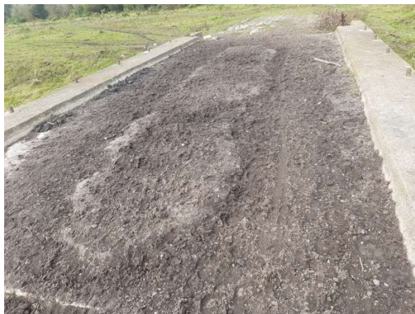
Fot. 130 Widok nawierzchni jezdni i kapy chodnikowej
