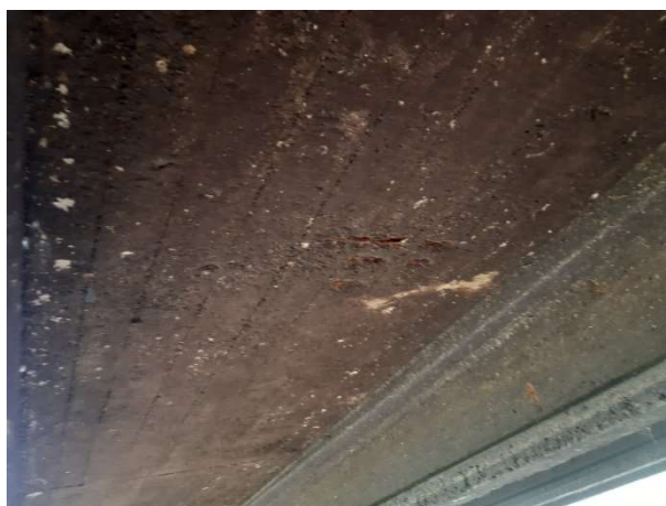
Fot. 129 Spodnia strona płyty z widoczną korozją
