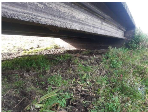
Fot. 93 Dźwigary główne
