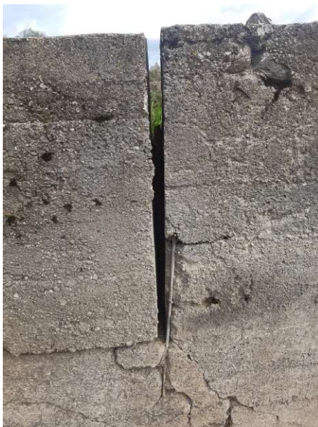
Fot. 127 Szczeliny dylatacyjne
