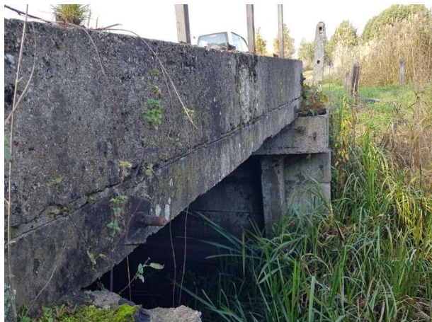
Fot. 148 Most na drodze numer 6 na Kanale Warnickim
