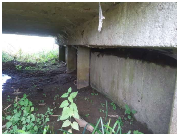
Fot. 153 Przyczółek mostu na drodze numer 13
