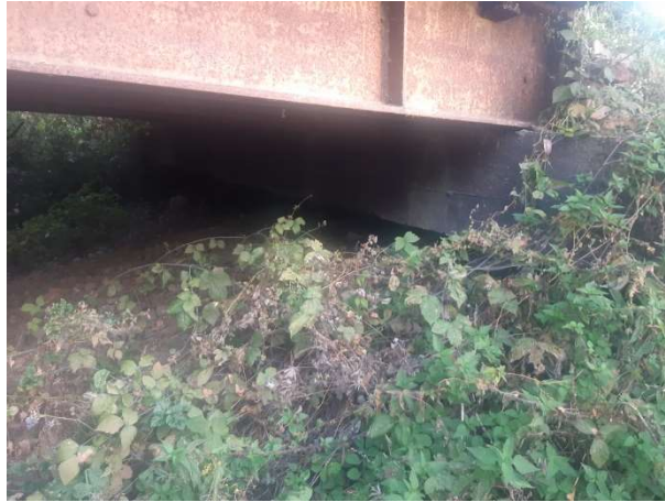
Fot. 111 Przyczółek wraz z nasypem drogi
