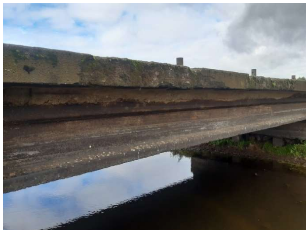
Fot. 71 Stan dźwigarów głównych
