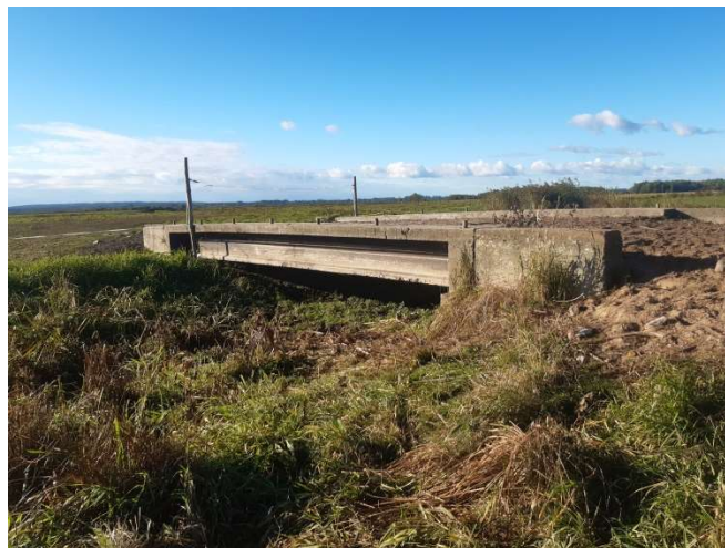
Fot. 155 Most na drodze numer 19(1)
