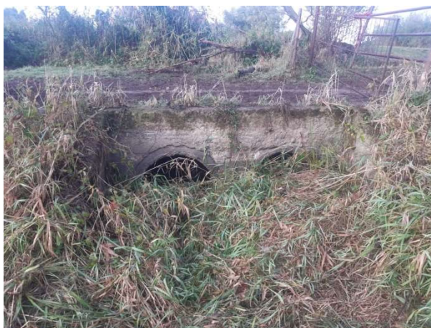
Fot. 81 Przepust okularowy "Kłopotowo Most"
