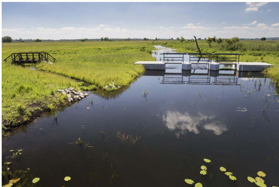
Ryc. 13 Wyremontowana infrastruktura urządzeń hydrotechnicznych na terenie Polderu Północnego Witnica (Fot. Łukasz Cieślak).
